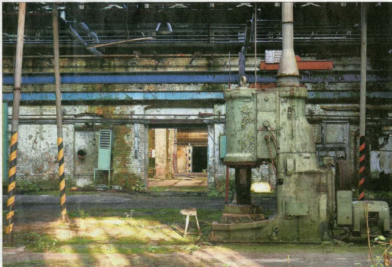
Blick in die Halle eines ehemaligen Reichsbahnausbesserungswerkes.
